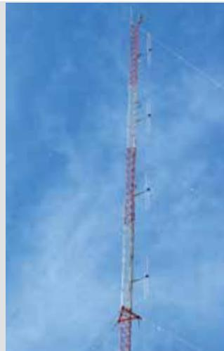
**Monopolos:** a diferencia de los dipolos, estas antenas utilizan un solo conductor como elemento irradiante; el otro polo se reemplaza por un plano de tierra. Suelen tener una longitud que corresponde a  $1/4$  o  $5/8$  de la longitud de onda de la frecuencia de interés.
